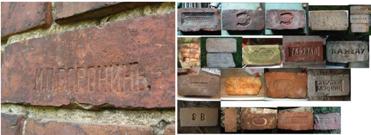
Рис. 1. Керамический кирпич: кладка и клеймы производителей
