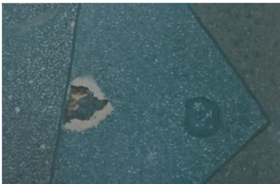
Рис. 2. Поры в мозаичном покрытии величиной до 2 мм
