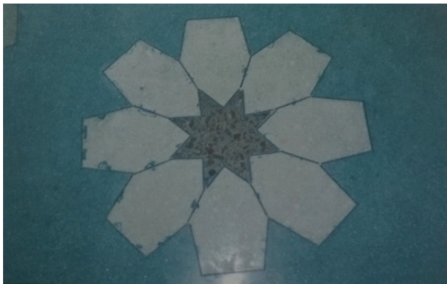
Рис. 6. Локальные участки полов размером до 5 см с включениями раствора непроектного цвета
