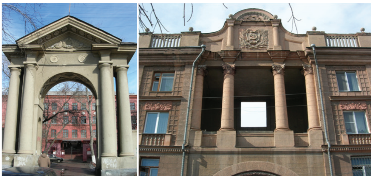
Рис. 5. Арка по ул. Ленинградская, 12 (слева); арка по ул. Чапаева, 22 (справа)
