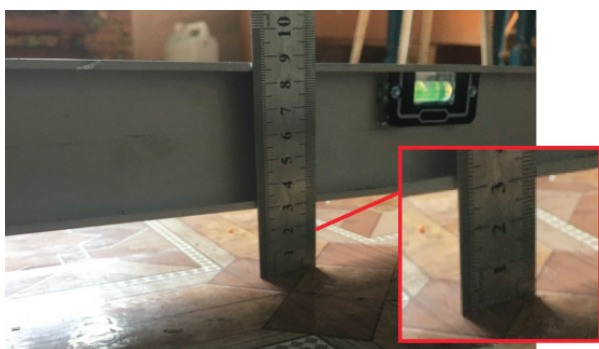
Рис. 5. Деформации пола на кухне 1 этажа
