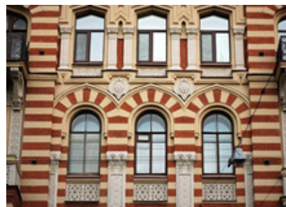
Рис. 6. Доходный дом Г.Ф. Вучиховского
