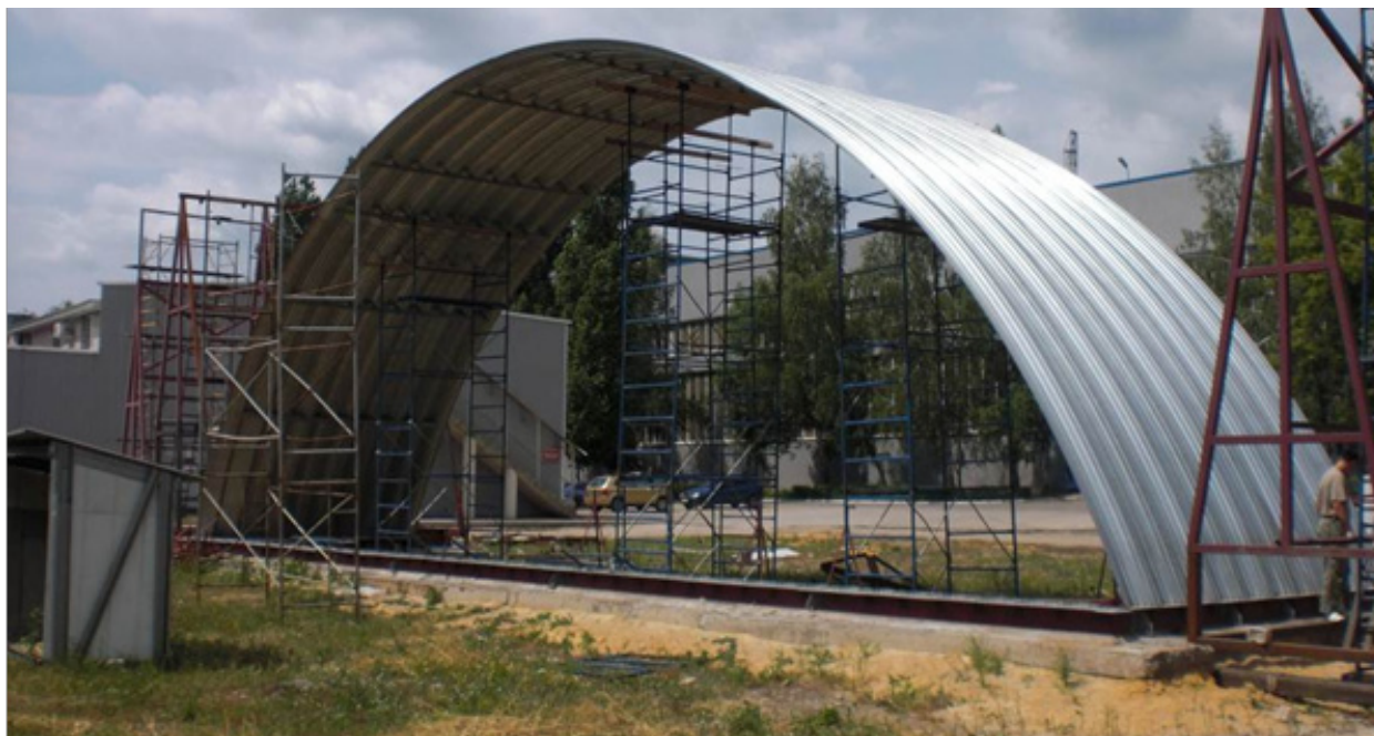
Рис. 4. Натурные испытания фрагмента здания
