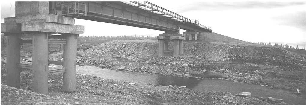
Рис. 1. Общий вид моста с термоопорами
