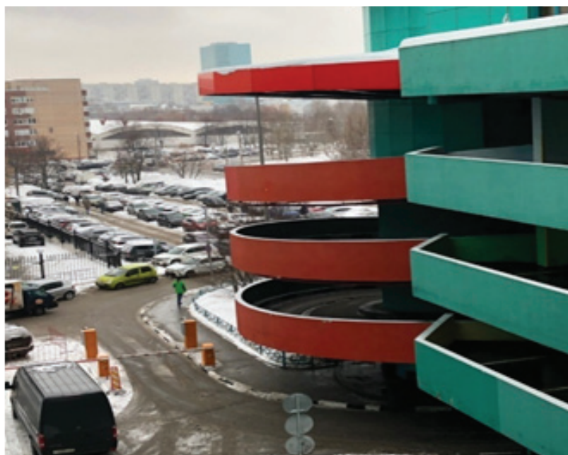
Рис. 5. Винтовая рампа автомобильной стоянки в ТЦ «Калужский» в г. Москва
