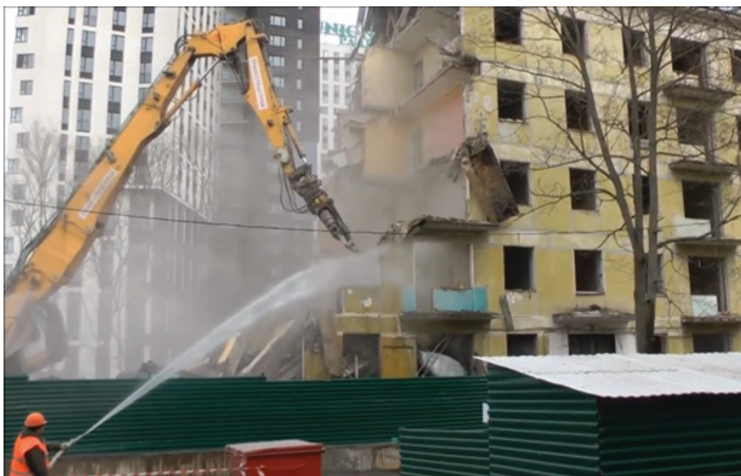
Рис. 1. Снос дома по адресу: г. Москва, Бульвар Генерала Карбышева, дом 9
