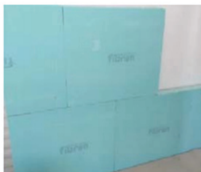
Рис. 2. Пример применения полистирольных плит
