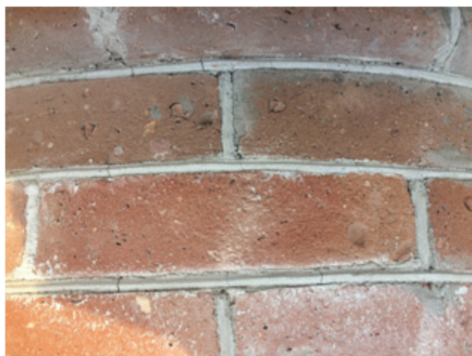
Рис. 7. Участок отчищенной от высолов кладки
