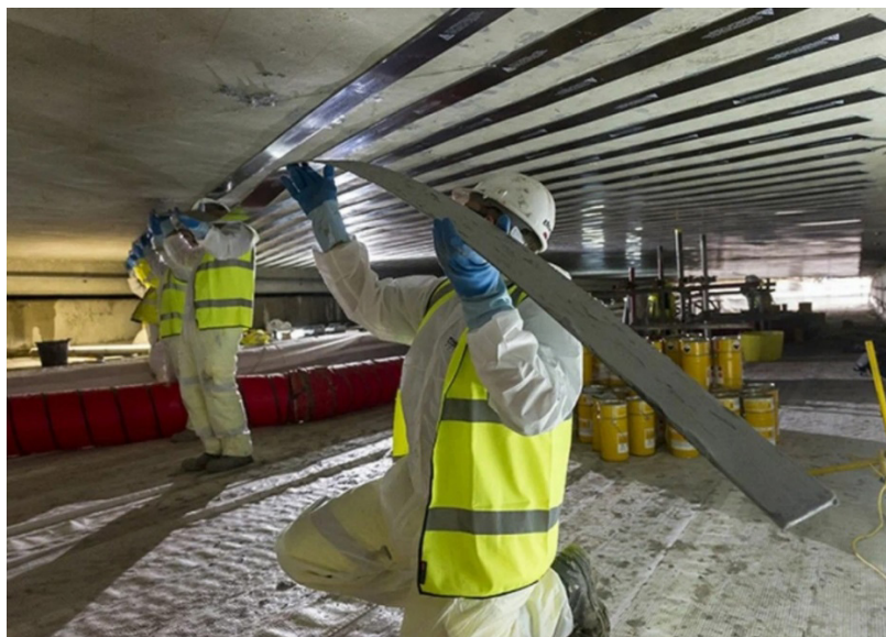
Рис. 3. Усиление железобетонного перекрытия методом EPT
