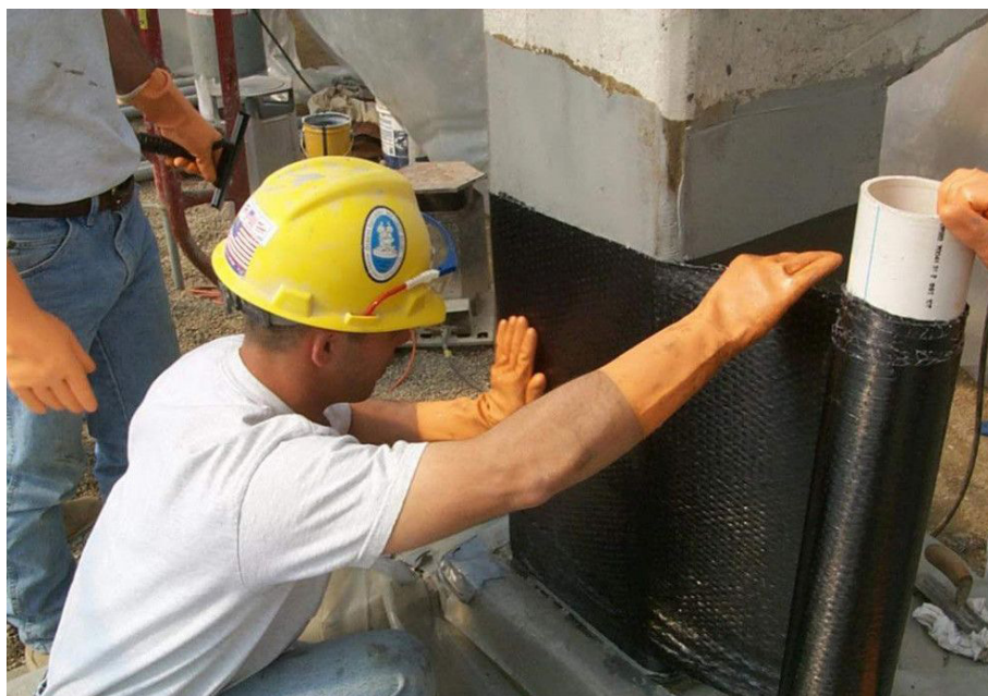
Рис. 2. Усиление железобетонной колонны методом EBR
