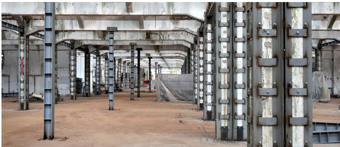
Рис. 1. Колонны промышленного объекта, усиленные внешним армированием с использованием стальной обоймы
