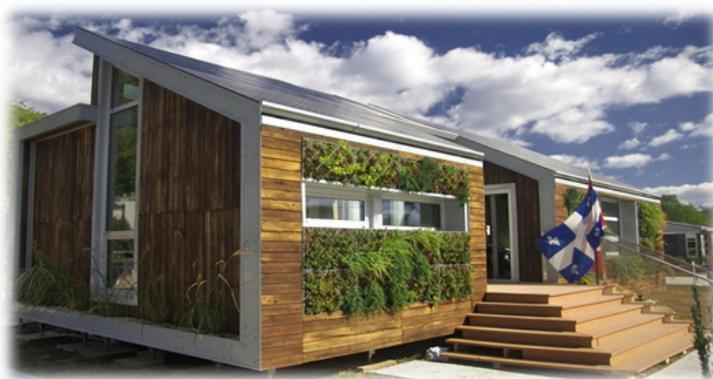
Рис. 7. Зеленые насаждения для снижения тепловой нагрузки
