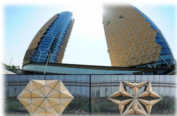
Рис. 5. Небоскребы с экранирующим фасадом из более 1000 подвижных элементов
