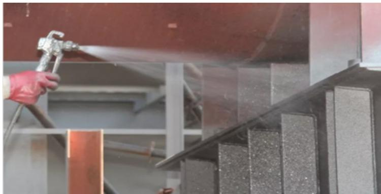
Рис. 4. Покрытие жидким огнезащитным составом металлических конструкций
