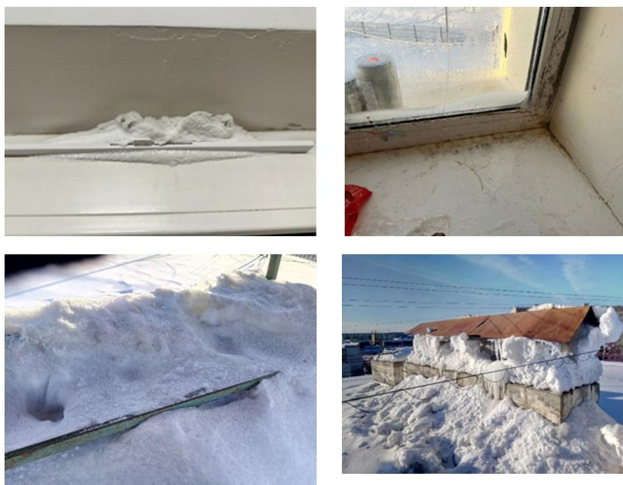
**Рис. 2.** Проблемные места в системах вентиляции жилых домов:
