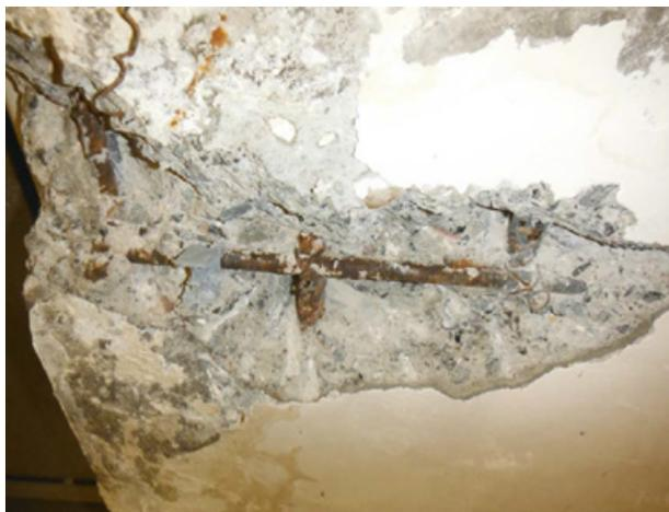
**Рис. 1.** Вскрытие железобетонной балки
