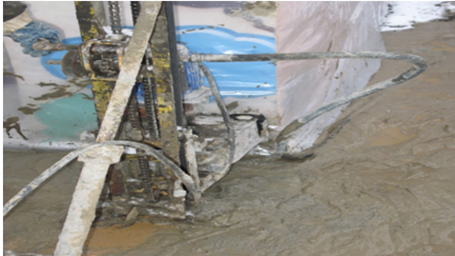
Рис. 3. Работы по усилению здания ТП грунтоцементными сваями
