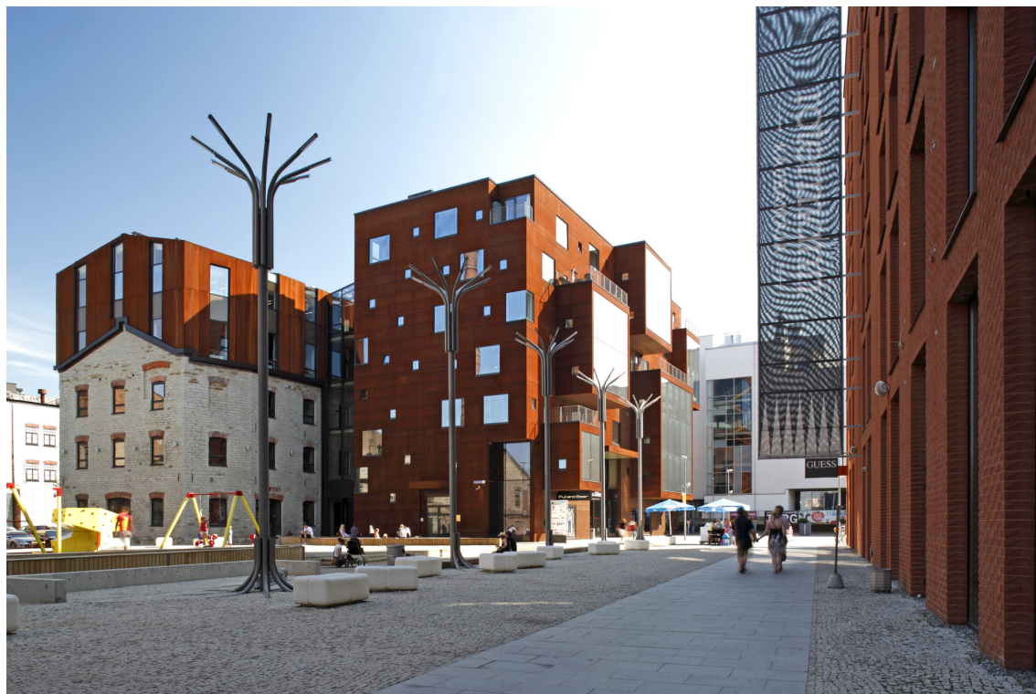
Рис. 2. Реконструкция исторических зданий квартала Ротерманни. Современный вид. Фотография из открытых источников
