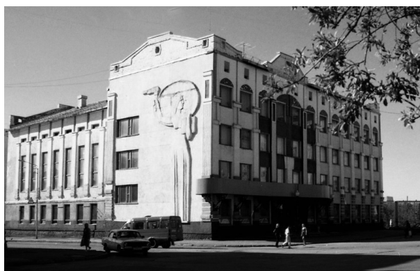
Рис. 7. Воркутинский Дом политпросвещения (архитектор В.Н. Лунев)
