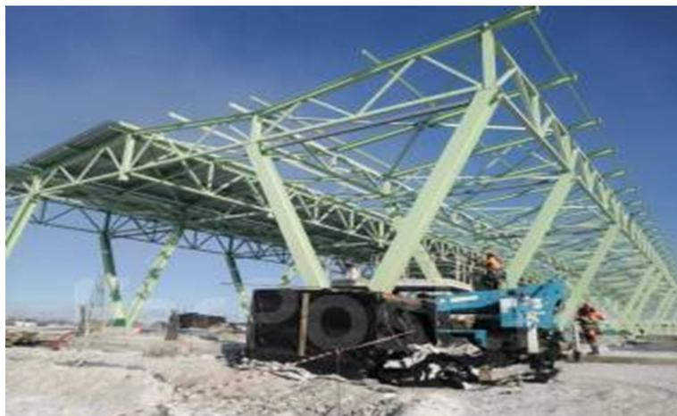
Рис. 1. Монтаж металлических конструкций каркаса здания
