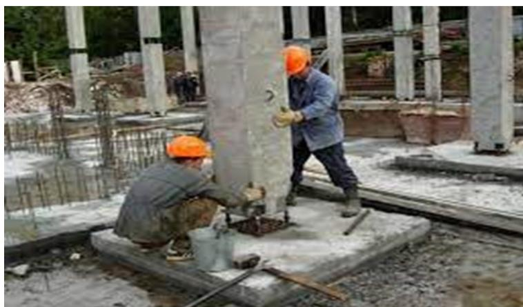
Рис. 2. Монтаж железобетонных колонн на фундамент с помощью анкерных болтов
