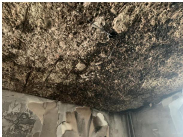
**Рис. 3.** Разрушение защитного слоя бетона, оголение арматурного каркаса, следы сажи и копоти на поверхности плиты перекрытия
