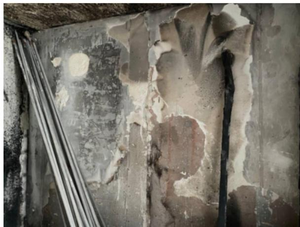
**Рис. 4.** Следы сажи и копоти на поверхности пилона
