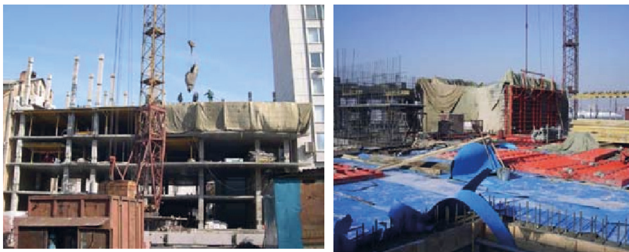
Рис. 2. Возведение многоэтажных зданий с поярусным выдерживанием конструкций
