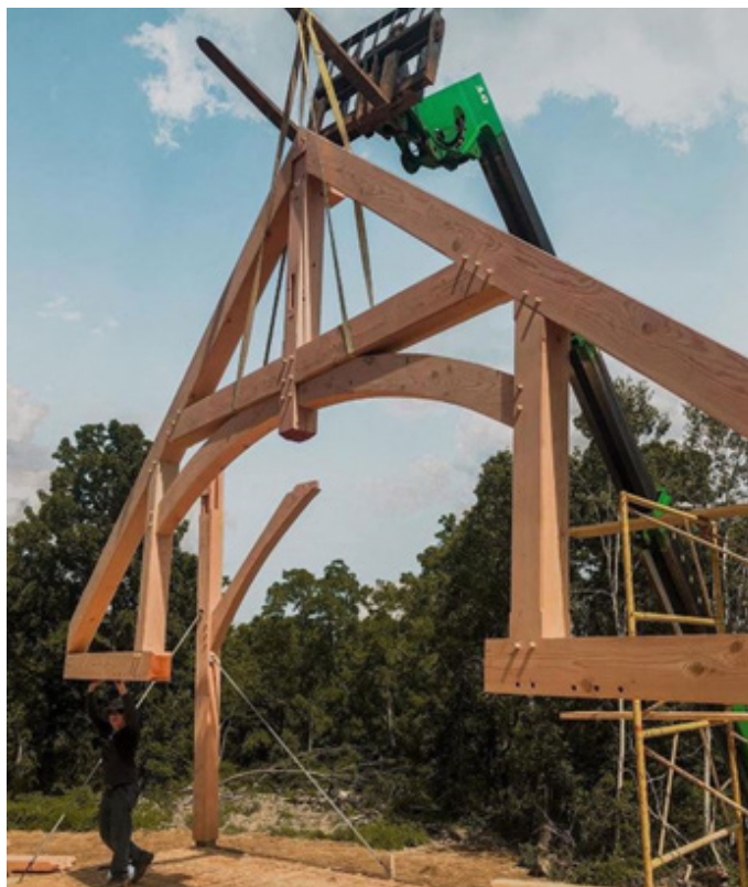
Рис. 4. Монтаж элементов каркаса по технологии Timber Frame
