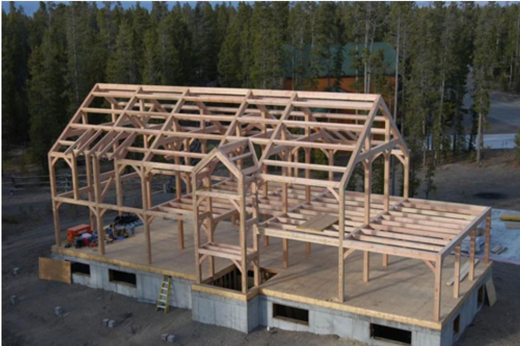
Рис. 1. Возведенный каркас по технологии Timber Frame
