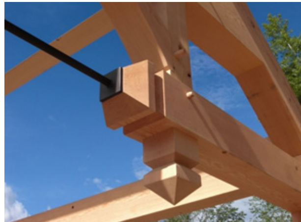
Рис. 3. Узел с применением стальной затяжки
