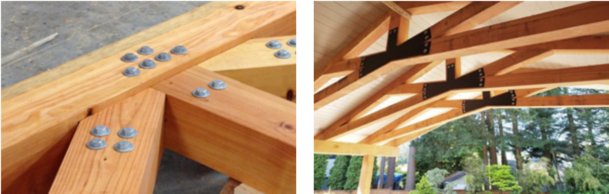
Рис. 6. Узлы деревянного каркаса с применением металлического крепежа
