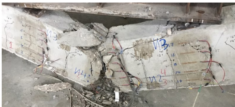
Рис. 6. Разрушение экспериментальной балки первой серии со сцеплением с бетоном
