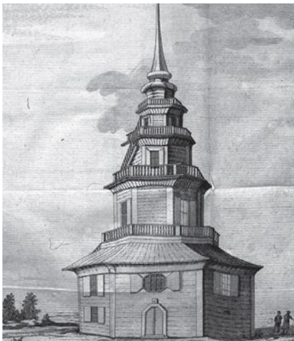
Рис. 1. Петропавловская церковь в Петрозаводске 1703 г. [8, табл. IX])
