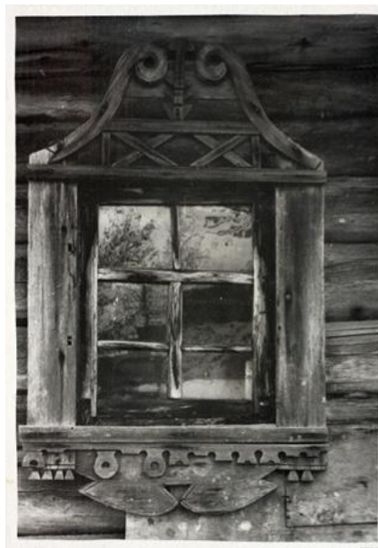
Рис. 9. Дом Мемоева из деревни Вешкелицы, XIX в. Наличник окна первого этажа. (Из фотоальбома «Памятники деревянного зодчества, находящиеся под охраной Управления по делам строительства и архитектуры МКХ КАССР» [36])
