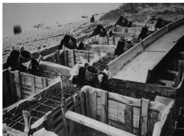
Рис. 5. Ростверк для погружения свай статической нагрузкой
