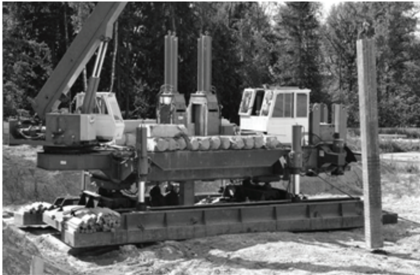
Рис. 2. Фото установки для задавливания свай статической нагрузкой
