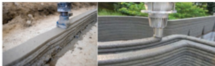
Рис. 1. Послойное нанесение сырьевой строительной смеси
