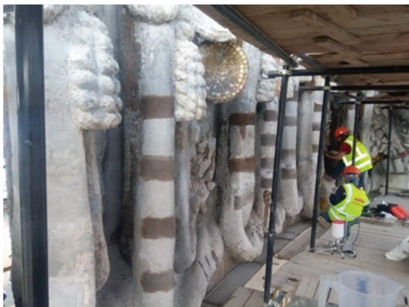
Рис. 1. Усиление бетонного основания картуша павильона «Центральный», ВДНХ, г. Москва
