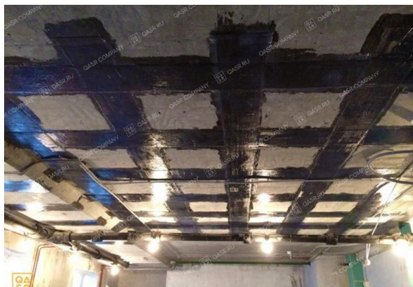
Рис. 4. Усиление перекрытия углеволокном
