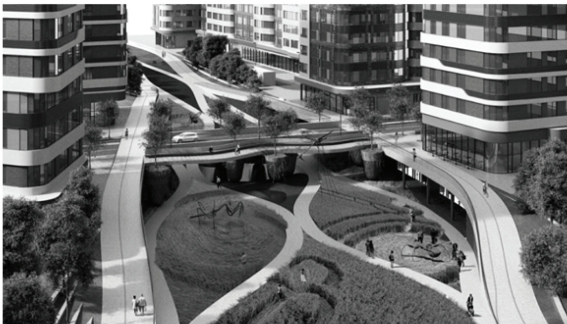
Рис. 1. Внутриквартальный путепровод в ЖК «Символ»
