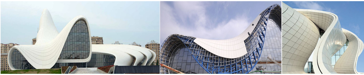
Рис. 8. Панели из стеклофибробетона – основной облицовочный материал в криволинейной ограждающей оболочке центра Гейдара Алиева в Баку (проект З. Хадид)
