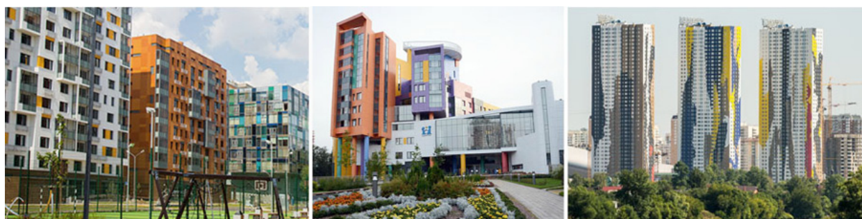
Рис. 9. Применение фиброцементных панелей с различным цвето-фактурным отделочным слоем позволяет решать сложные архитектурно-композиционные градостроительные задачи
