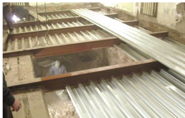
Рис. 2. Организация рабочей зоны при устройстве перекрытий с применением листов профилированного настила из оцинкованной стали
