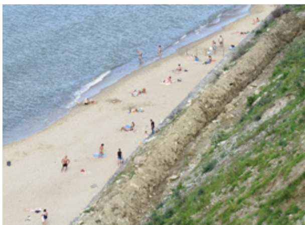
Рис. 5. Подошва склона, укрепленная габрионной подпорной стенкой
