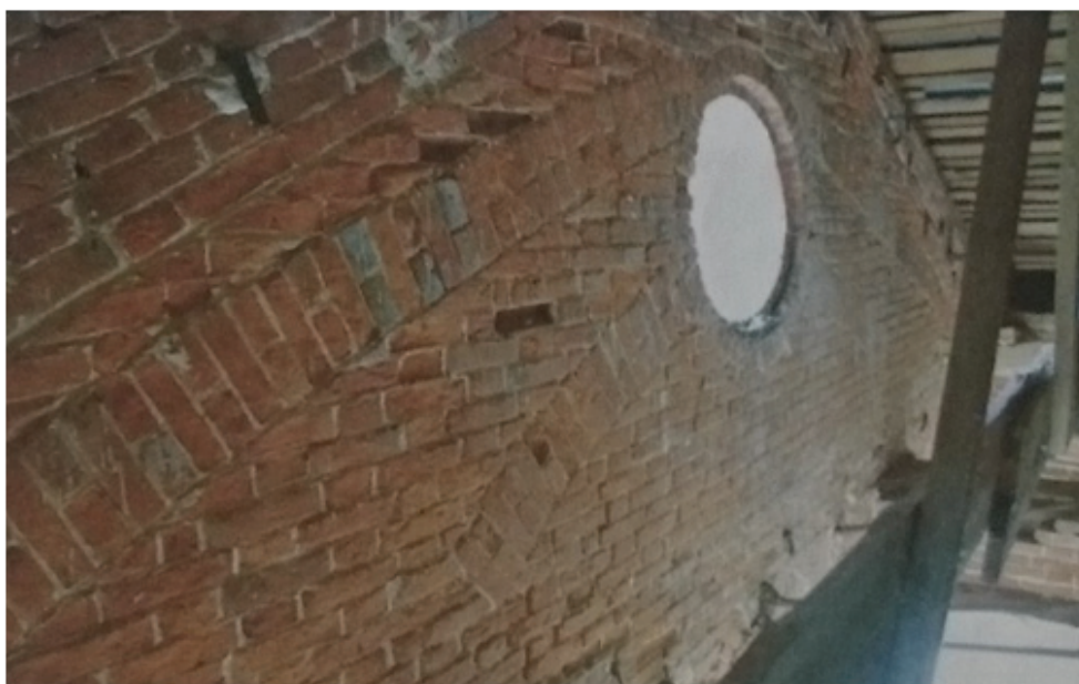
Рис. 6. Фронтон портика с разгрузочными арками
