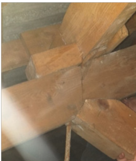
Рис. 9. Недостаточное количество крепежных элементов (прогон опирается на верхний пояс, подпорный брусок держится 2 гвоздями)
