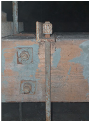
Рис. 7. Не докрутили гайку
