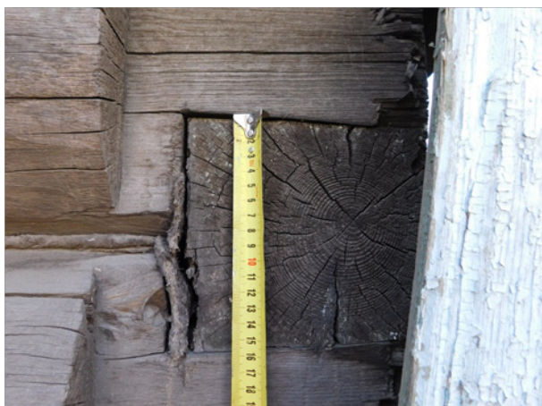
Рис. 4. Щели в угловых врубках
