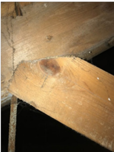
Рис. 6. Неплотное прилегание элементов фермы
