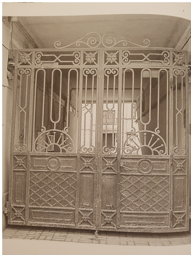
Рис. 8. Доходный дом страхового общества «Саламандра», 1909 г., арх. М.М. Перетяткович, Н.Н. Веревкин, Гороховая ул., д. 4
