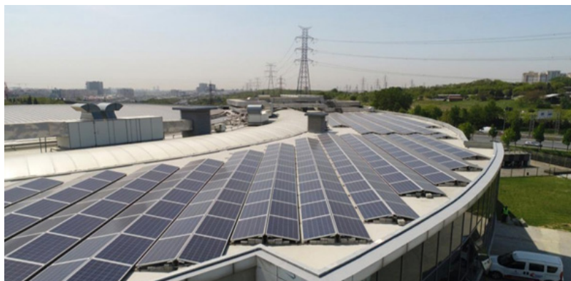
Рис. 1. Размещение солнечных панелей на крыше здания, по данным С. Алкана с соавторами [16]
