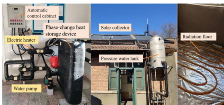
Рис. 5. Экспериментальная платформа для всей системы отопления, по данным С. Лв с соавторами [20]
