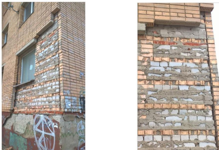
Рис. 3. Пример обрушения кирпичной кладки [4]
