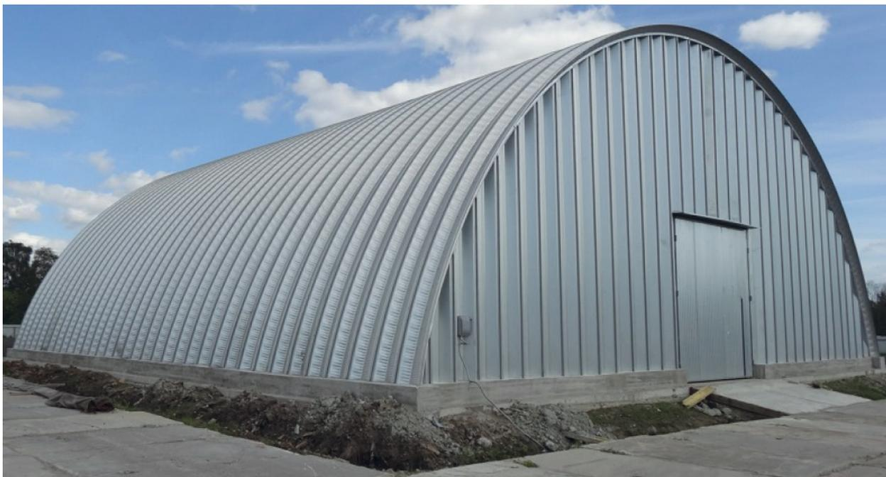
**Рис. 3.** Пример арочного бескаркасного здания с использованием профилированных листов одинарного гофрирования
