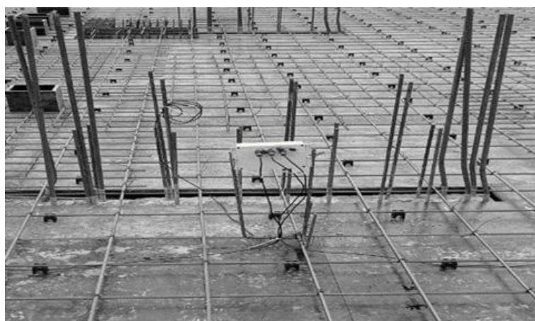
Рис. 2. Установка системы термомониторинга в плите перекрытия
