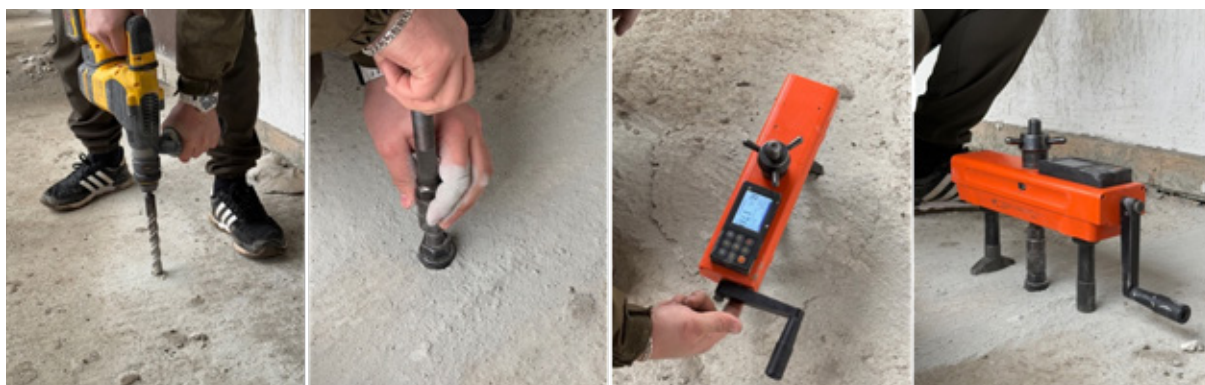
Рис. 2. Измерение прочности бетона прибором «ОНИКС-1.0С»
