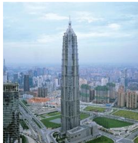
Рис. 6. Лжин Мао Башня, г. Шанхай
